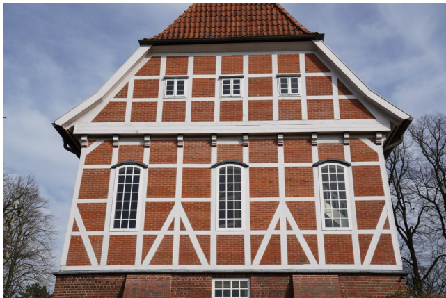
Keine Bretterwand! 2012/13 Sanierung Westgiebel
